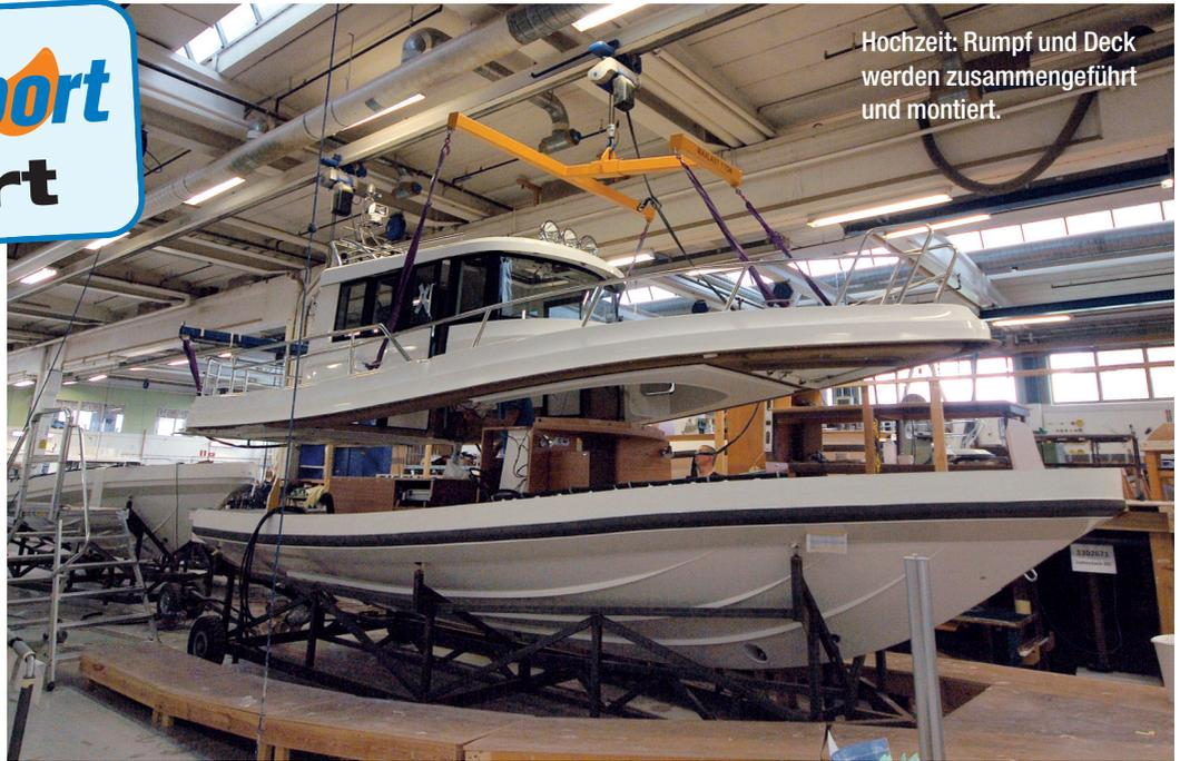
Hochzeit: Rumpf und Deck werden zusammengeführt und montiert.
